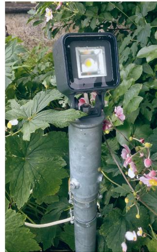
Die alten stromfressenden Scheinwerfer wurden vor Kurzem durch neue LED-Scheinwerfer ersetzt. Vorab musste alles genau ausgemessen werden damit die Kirche optimal ausgeleuchtet wird und möglichst kein Streulicht entsteht. Wir freuen uns sehr, dass die Kirche von nun an stromsparend in einem schönen Licht angeleuchtet wird.
